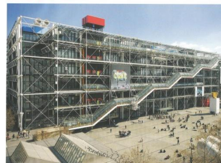
Le Centre Pompidou
